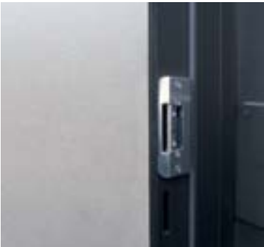
Riscontro serratura elettrica. Electric lock striker. Закрывание электрического замка.
