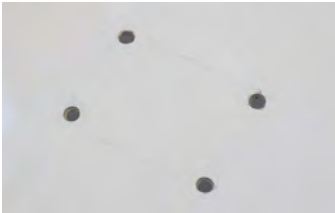
IT 2_ Foro: attraverso i foretti diamantati eseguire il foro in corrispondenza del punto di congiunzione delle linee tracciate sulla lastra (fori tondi di circonferenza 7/8 mm).
