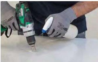
IT 2_ Eseguire il foro con un'angolazione di 75°-85° e penetrare nella lastra per circa 1-2 mm di profondità.
