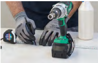
IT 1_ Adagiare la lastra Mega su un banco da lavoro o un supporto compatto e non scivoloso come legno o cemento. Bagnare con acqua l'area dove verrà praticato il foro.
