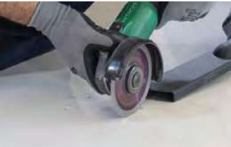
IT 3_ Coniungere il foro con l'estremità della lastra attraverso apposita smerigliatrice angolare equipaggiata con disco diamantato.
