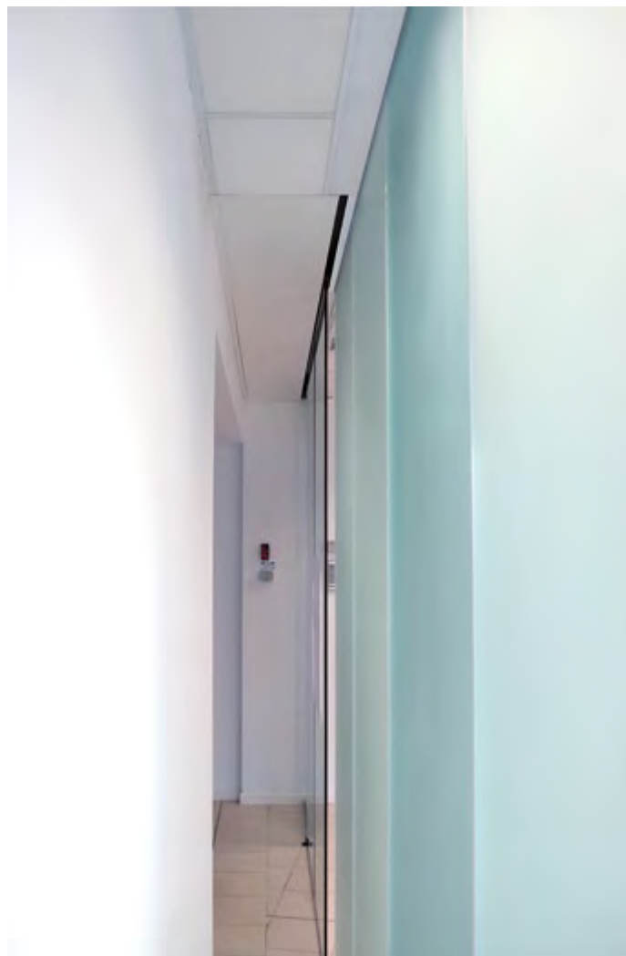
Botola Fantasmino anta S.A. (stratifica di alluminio) con stipite speciale su tre lati e traverso rientrante per ispezione scorrevoli automatici a soffitto.
