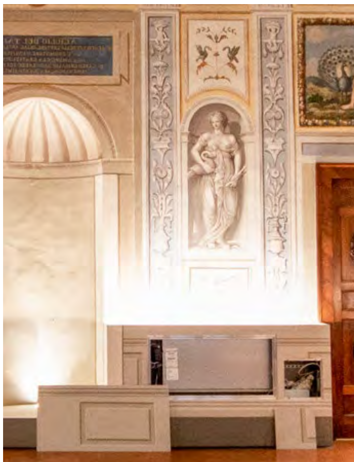
[2] Faint col per chiusura ventilconvettore senza areazione, posizionato nella boiserie di un palazzo storico. Faint col for fan coil closure without ventilation, located in the wood panelling of a historic palace.
