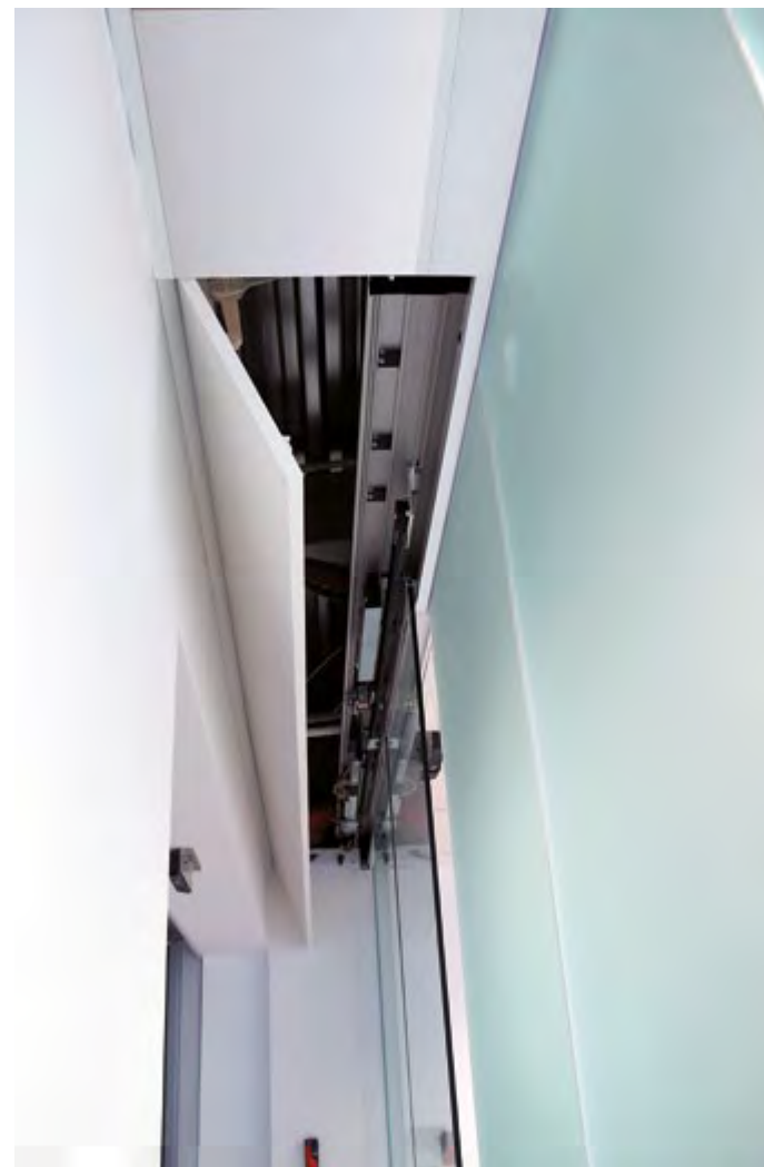
Botola Fantasmino anta S.A. (stratifica di alluminio) con stipite speciale su tre lati e traverso rientrante per ispezione scorrevoli automatici a soffitto.
