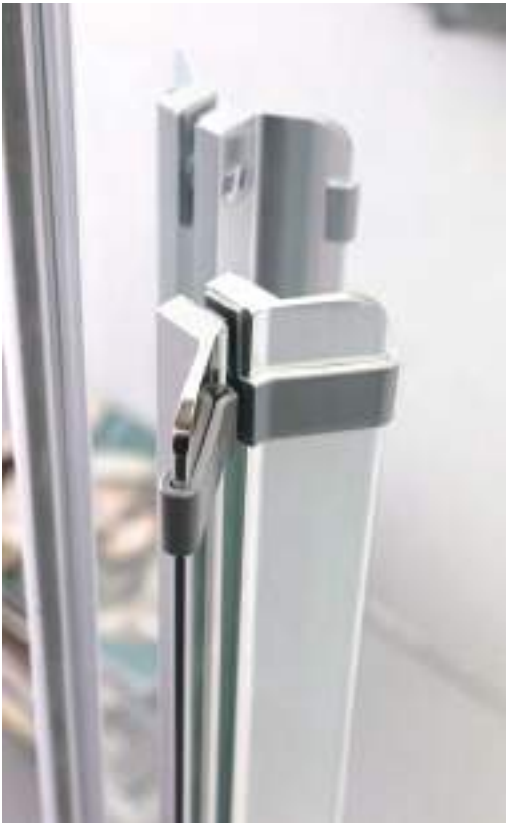
DETTAGLIO DI GOMMINI "ANTI-URTO" DELLA DOPPIA MANIGLIA
